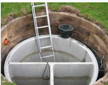
Nachrüstung einer alten DDR-Grube mit neuem Beton-Behälter
